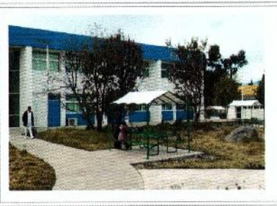
FOTO LUMINARIAS SOBRE POSTES ANDADOR EDIFICIO "E" LABORATORIOS
