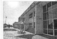
Trabajos de Pintura (edificio "C" y "F")
