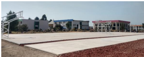
F1: Fachada principal
