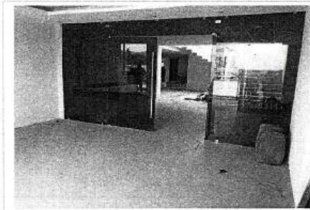
F5: Interior de obra
