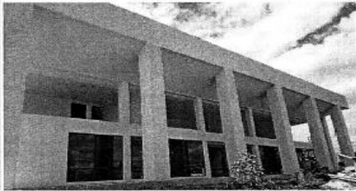
F1: Fachada principal
