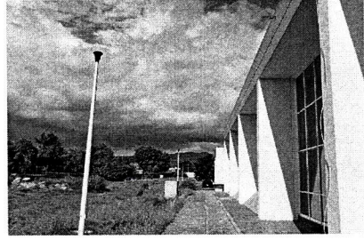
FOTO CAMINO ACCESO A ESTACIONAMIENTOS DOCENTES PLANTEL OCOYOACAC
