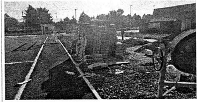
RELLENO COMPACTADO CON MATERIAL PRODUCTO DE EXCAVACIÓN EN CEPAS
