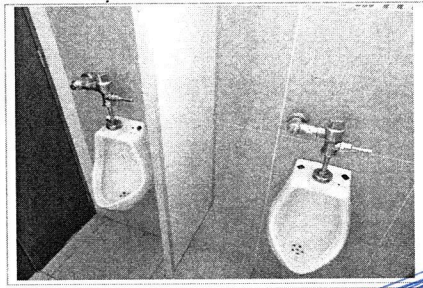
FOTO BAÑOS PLANTEL AMANALCO
