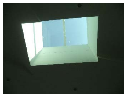
Imagen 24. Colocación de plafones en el área de Quiropráctica de la clínica
