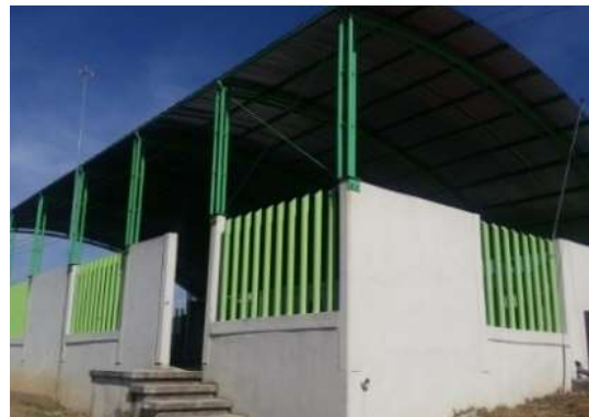
Imagen 51. Construcción domo sub-estación
