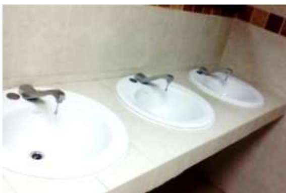
Imagen 44. Mantenimiento de sanitarios.
