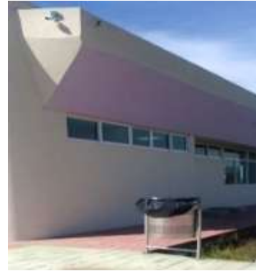
Imagen 47. Colocación de cestos de basura.
