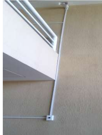
Imagen 43. Colocación de Botón de Pánico.
